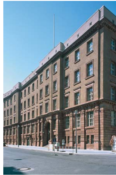
Fassade nach Instandsetzung . Foto Reuss
