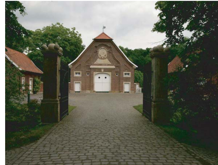
Haus Rüschaus nach der Instandsetzung
