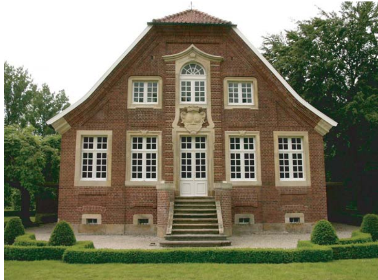
Haus Rüschaus nach der Instandsetzung
