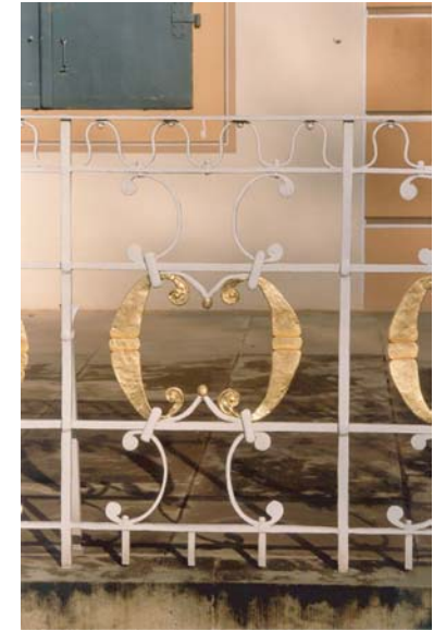
Geländer nach Restaurierung Foto H & K GmbH
