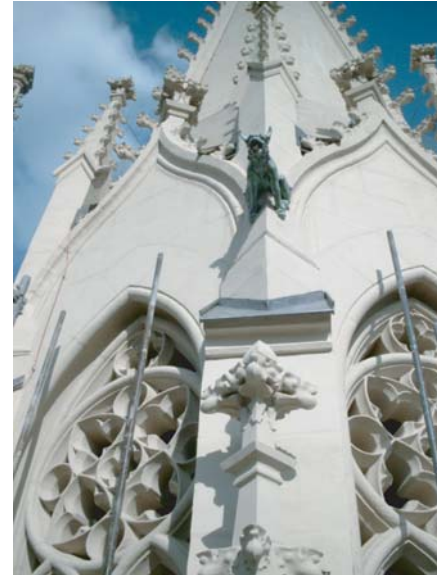
Turmdetail nach Sanierung Foto H & K GmbH
