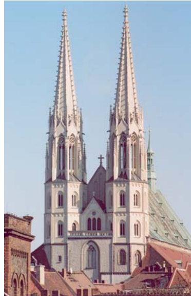
Westtürme nach Sanierung Foto H & K GmbH
